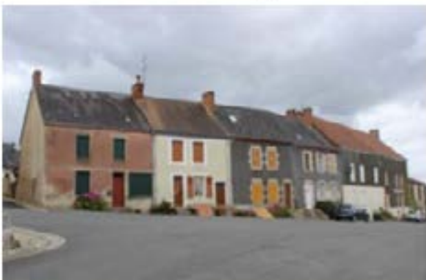
Maisons de bourg avec toiture à deux pans
